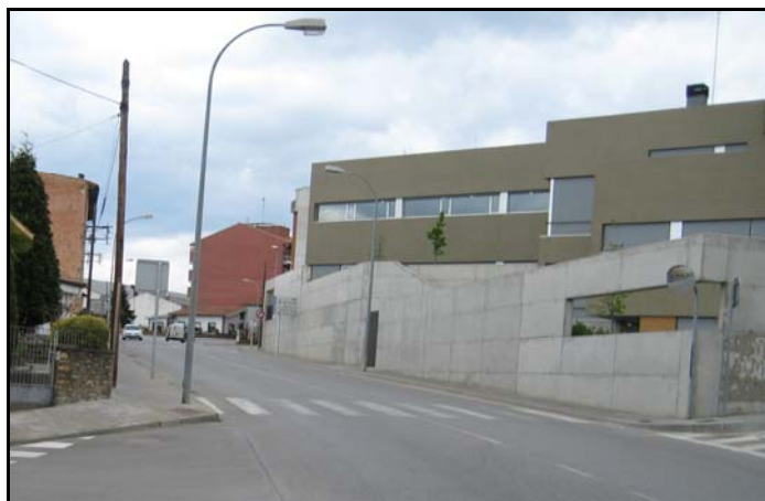
Imatge 5: pas de vianants al carrer de la Diputació, cruïlla amb el carrer de Sant Sebastià. En aquest cas particular seria molt aconsellable la construcció d'un pas de vianants elevat.
