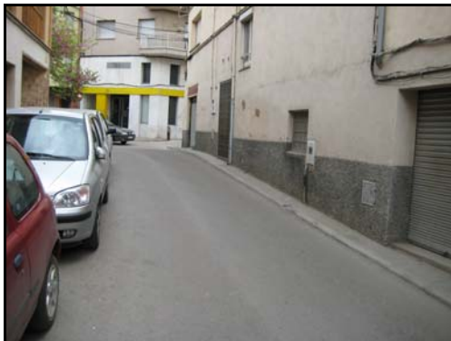
Vorera d'amplada insuficient i aparcament indegut de vehicles.
